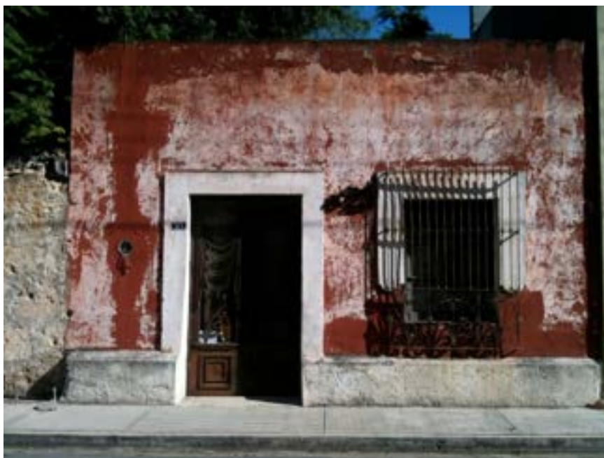
Imagen 26 - Edificación histórica en la calle Libertad, en el Casco Urbano del municipio de San Pedro Garza García, Fotografía: IMPLAN San Pedro Garza García, 2011
